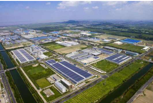
黄梅县2017年度25.5MW集中式光伏 扶贫电站项目
