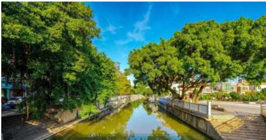
均安镇鳧洲河 及华安涌综合整治工程
