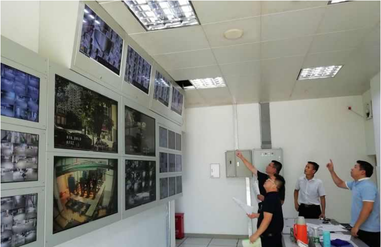
深圳市盐田区(海桐居) 监控系统改造项目
